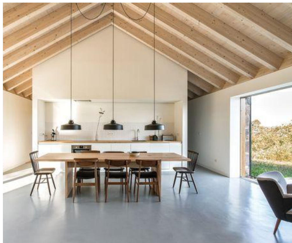
Otevřený krov v hlavním obytném prostoru
